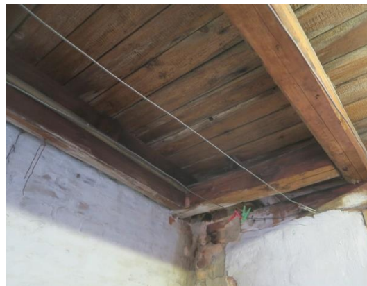
Foto 2, hvid belægning på tagbrædderne ved skorstenen. Foto 3, hvide pletter på tagbrædderne.
