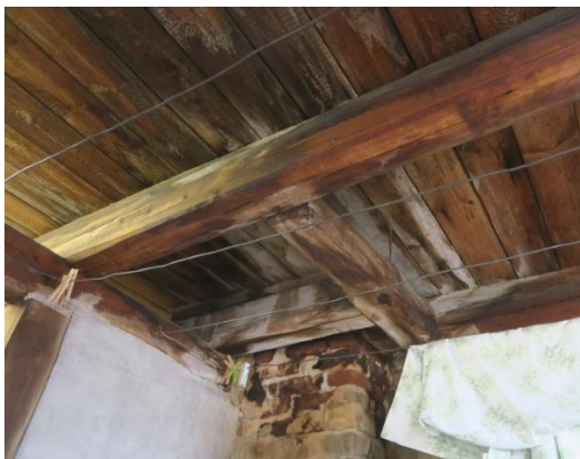
Foto 2, hvid belægning på tagbrædderne ved skorstenen. Foto 3, hvide pletter på tagbrædderne.
